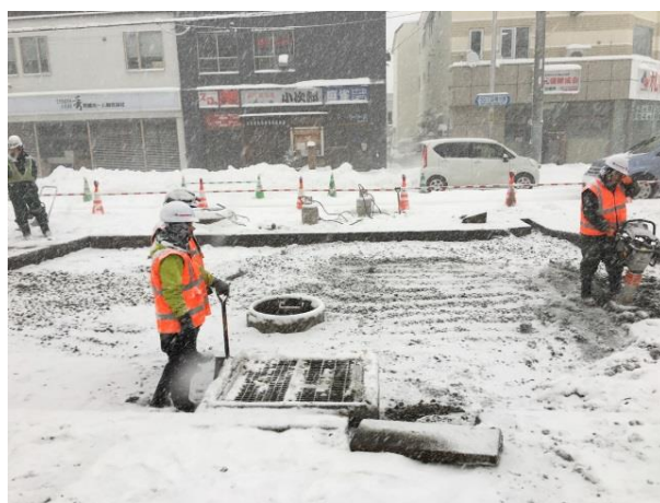
吹雪について行われた緊急工事（11日朝）
